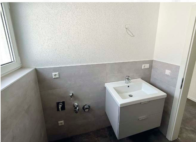
August-Lämmle-Straße 36, EG links, Bad neu
